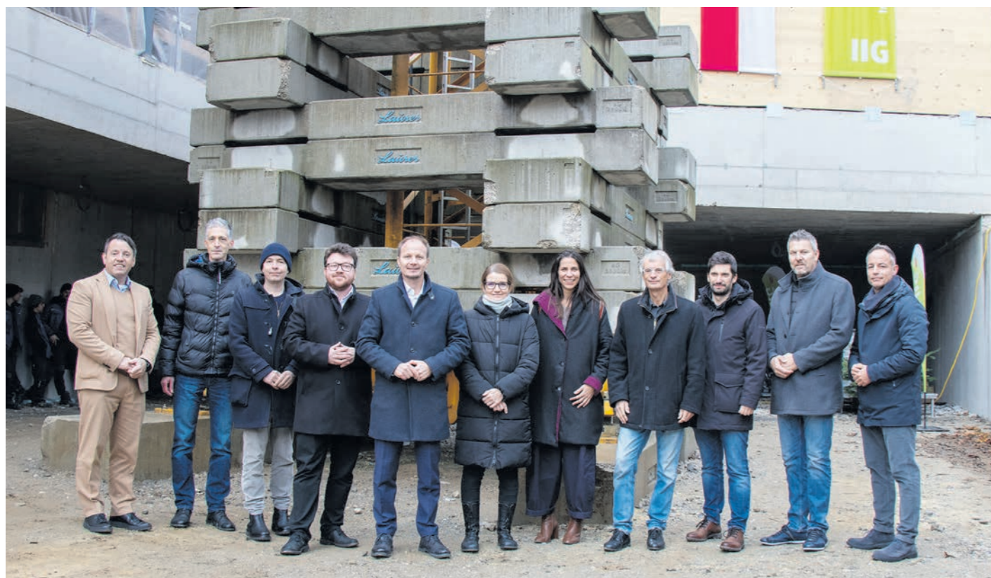
IIG-Geschäftsführer Franz Danler, Gemeinderat Mario Dallaserra, Architekt Mario Gasser, Stadtsenat-Ersatzmitglied Benjamin Plach, Bürgermeister Johannes Anzengruber, Direktorin Petra Eichler, Stadträtin Janine Bex, Geschäftsführer Thomas Huter (Baufirma Huter & Söhne GmbH), Tobias Huter (Baufirma Huter & Söhne GmbH) sowie Gemeinderat Thomas Mayer und Stadtrat Markus Lassenberger bei der Firstfeier am Campus Arzl.
