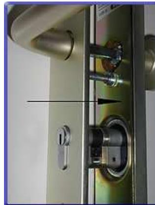
Es werden einbruchshemmende Schutzbeschläge nach Önorm B 5455 empfohlen.
