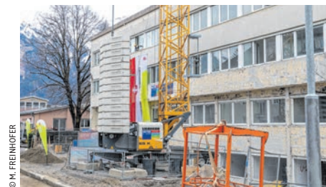
Am Domanigweg 3 in Amras entsteht eine neue Sozialeinrichtung. Gebaut wird sie von der IIG.
