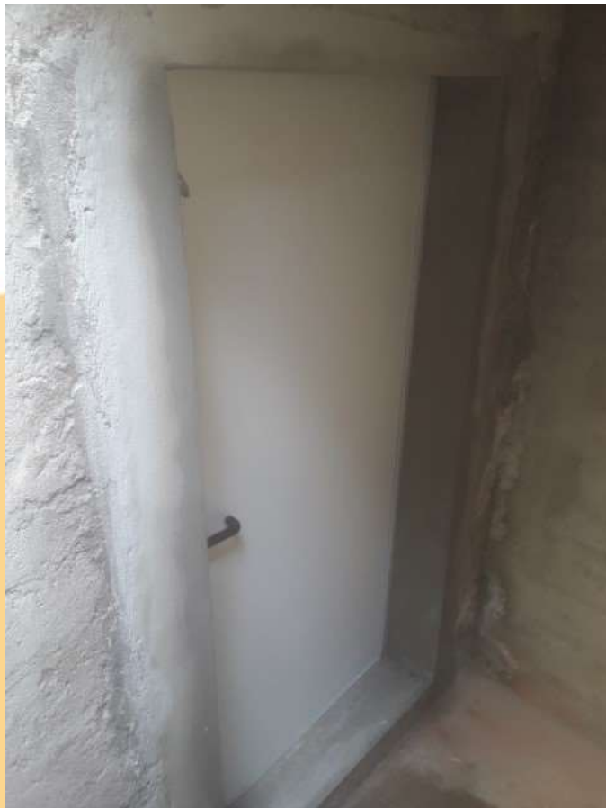
Austausch einer Metalltüre im Heizraum bei der Verwaltung am Westfriedhof
