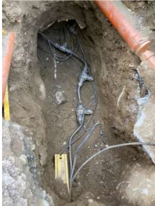
Reparaturarbeiten an der Elektroanlage im neuen Tail am Ostfriedhof
