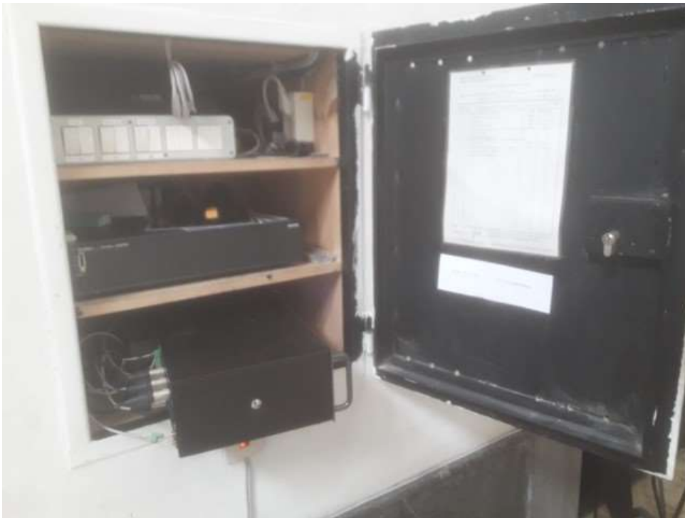
Reparatur des Verstärkers für Die Beschallungsanlage am Westfriedhof
