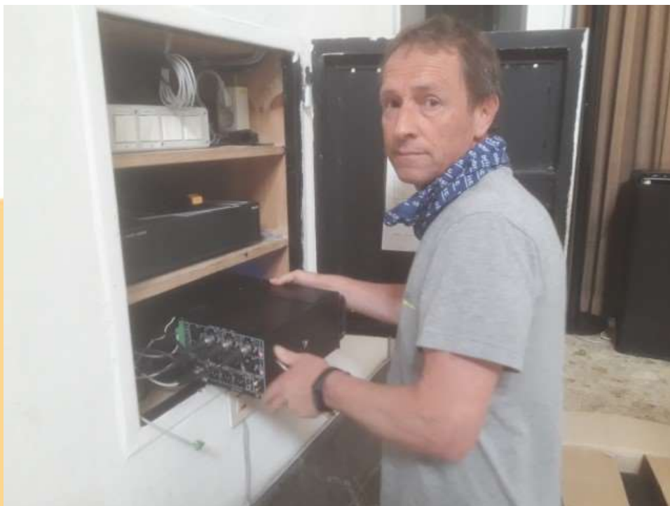
Reparatur des Verstärkers für Die Beschallungsanlage am Westfriedhof
