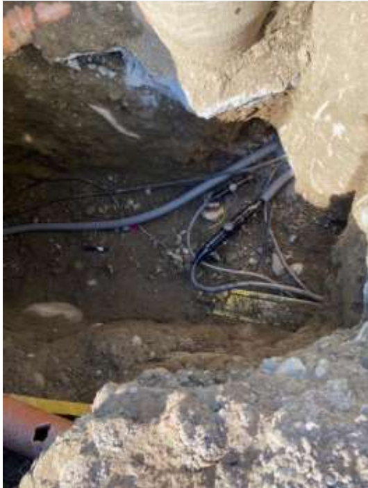
Reparaturarbeiten an der Elektroanlage im neuen Tail am Ostfriedhof
