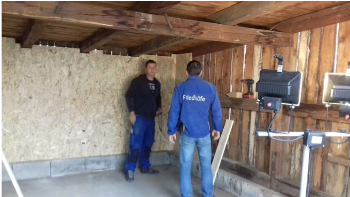
Sanierung der des Lagerschuppens am Ostfriedho
