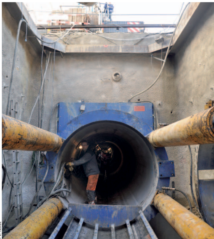
Beeindruckende Dimensionen: Der Kanalvortrieb am Bozner Platz.
