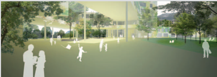
Das zukünftige Wohnheim O-Dorf ist im Parkbereich auf fünf bis acht Meter hohe Pfeiler aufgestellt. Darunter entsteht ein durchgängiger Bereich mit öffentlich zugänglichem Heimcafé.
