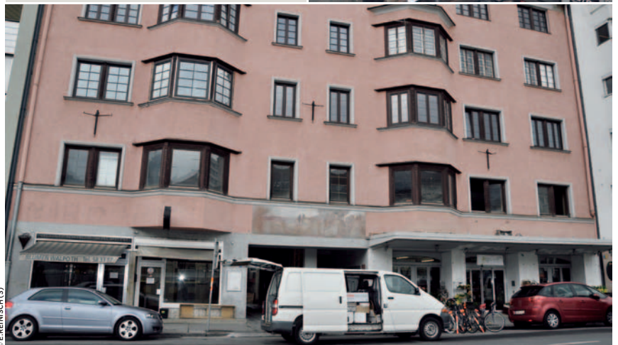
Das Vordach wird über die gesamte Hausfassade verlängert.
